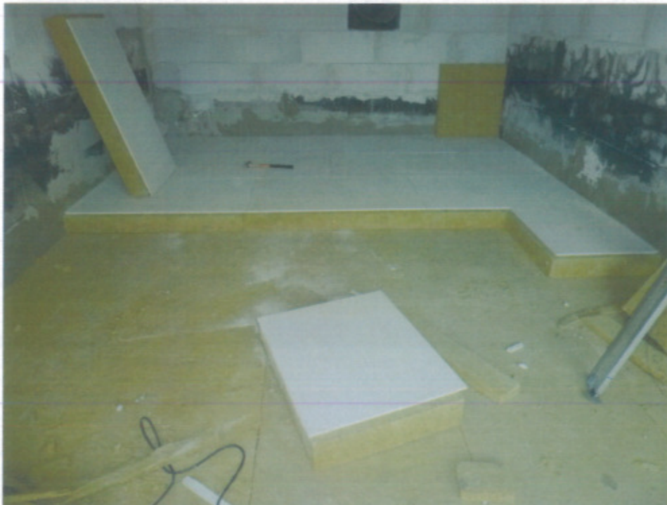
Bild 8 (P1030887.jpg): Verlegen Steinwolle und Gipsfaserplatten
